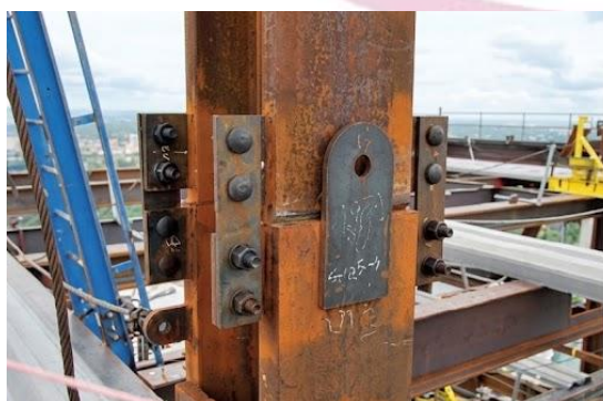
Left: Tension Control bolt.
